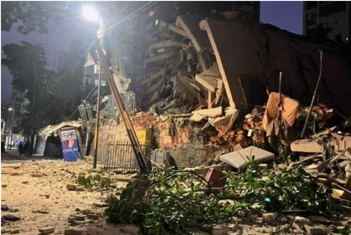
Fig.4. Falla de colapso de panqueque de edificios, característico de este terremoto.
