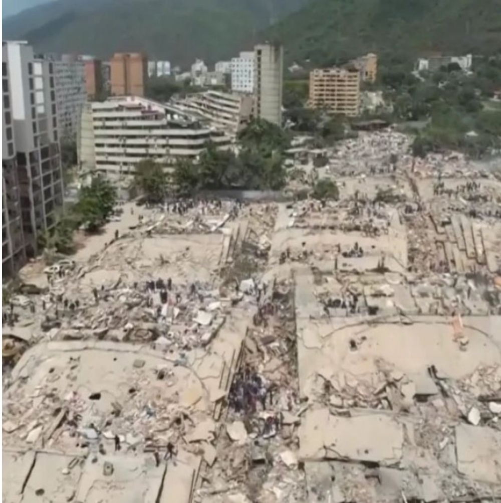
Fig.5. Colapsos estructurales observados durante el segundo evento sísmico M_W = 7.5 .
